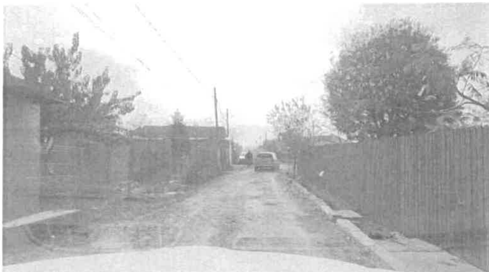
Fotografii amplasament – Strada Cantonului – Tronson 2
