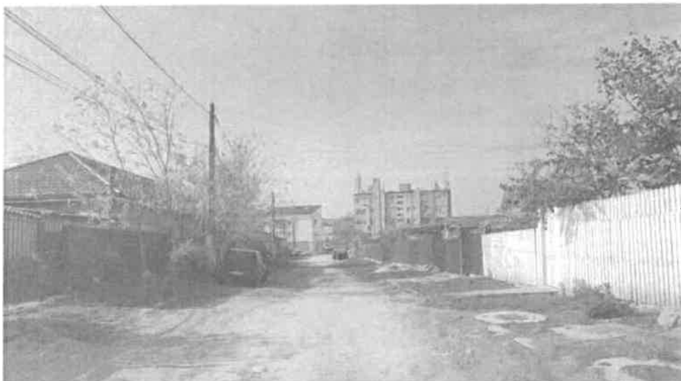
Fotografii amplasament – Strada Stadionului – Tronson 1, 2
